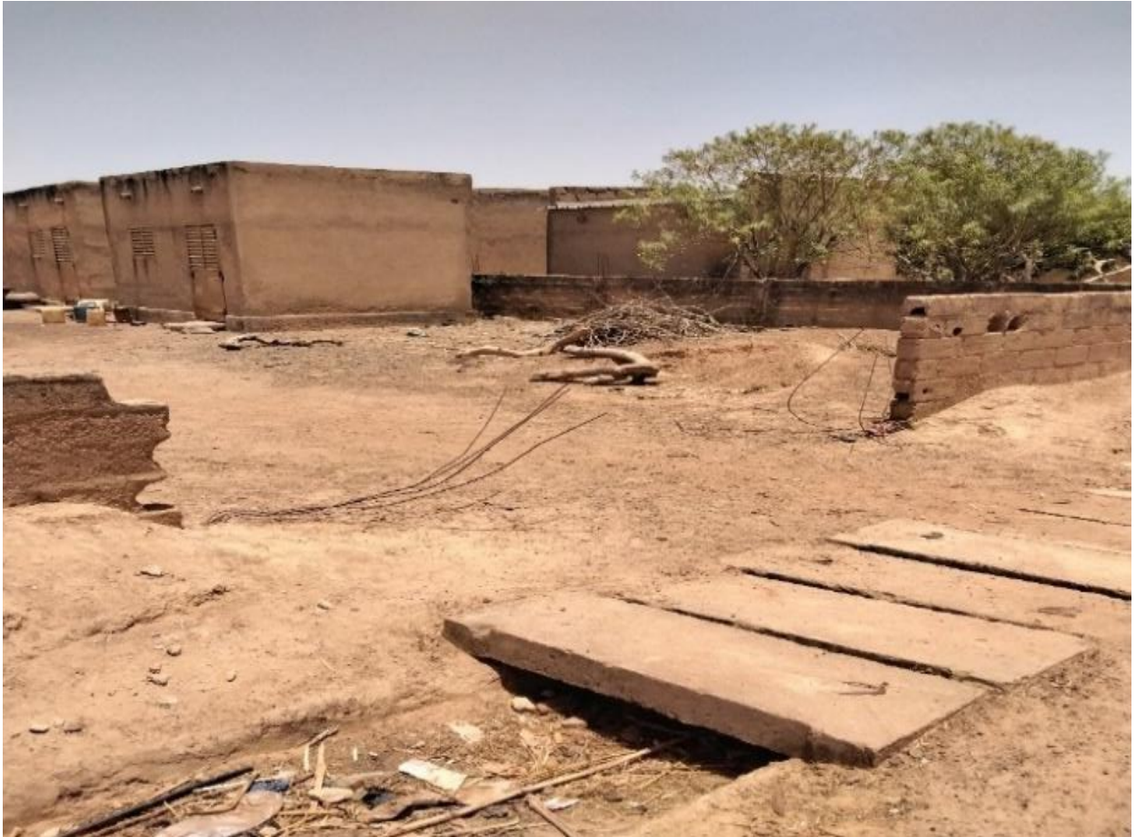
Mûr de clôture des maisons des PAP d'un village à Donsin (Plateau central)
