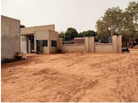
Une vue de l'usine de production d'oxygène Banfora (Cascades)
