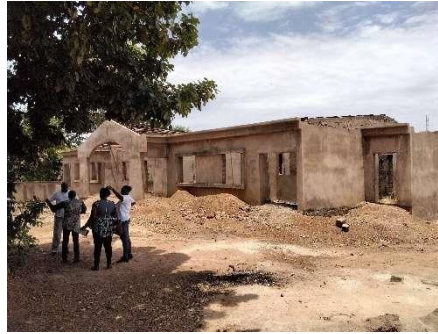
Une vue de l'usine de PEC des maladies arrêt au CHR de Gaoua (Sud-Ouest)
